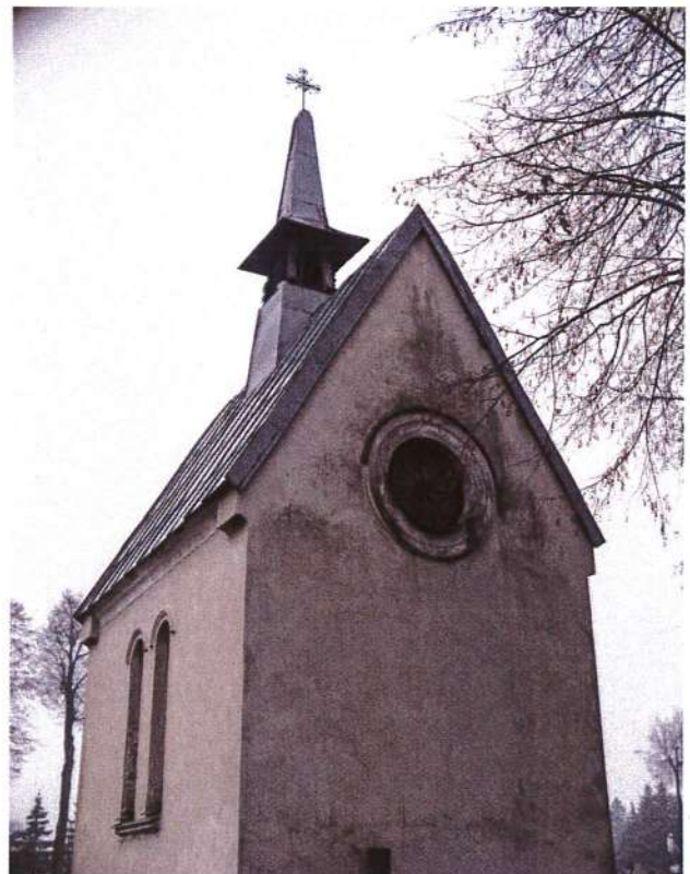
Zambrów kaplica rodziny Woyczyńskich z 1870 r., elewacja widok z południowego wschodu.
