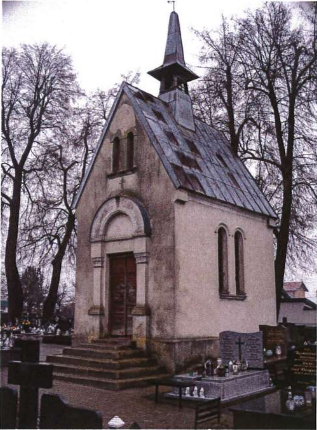
Zambrów kaplica rodziny Woyczyńskich z 1870 r., elewacja widok z południowego zachodu.
