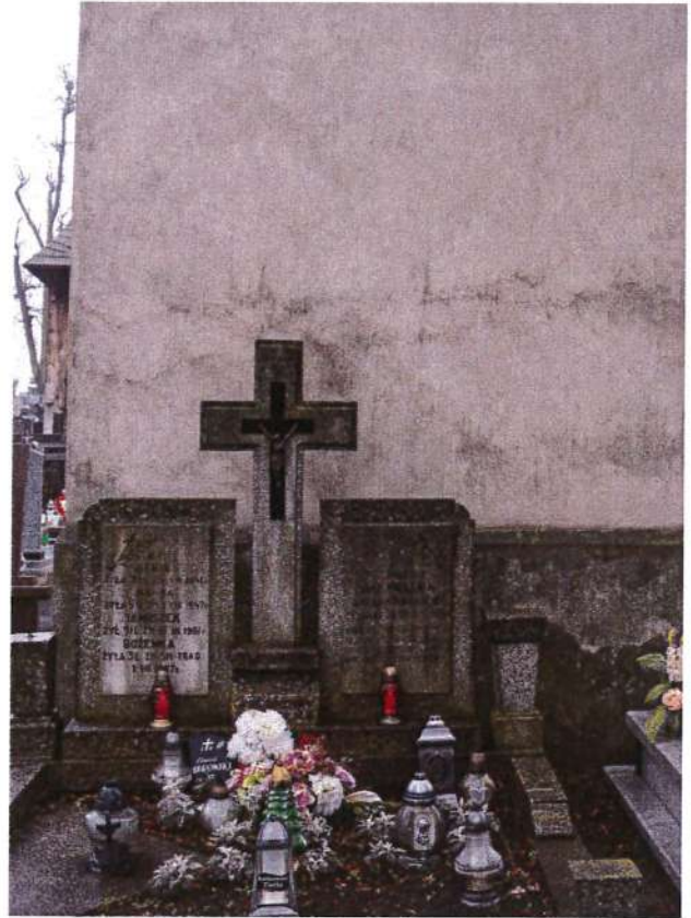
Zambrow kaplica rodziny Woyczyńskich z 1870 r., elewacja wschodnia stan przyziemia.
