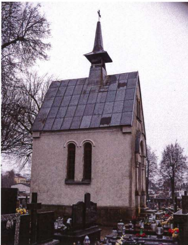
Zambrow kaplica rodziny Woyczyńskich z 1870 r., elewacja północna.
