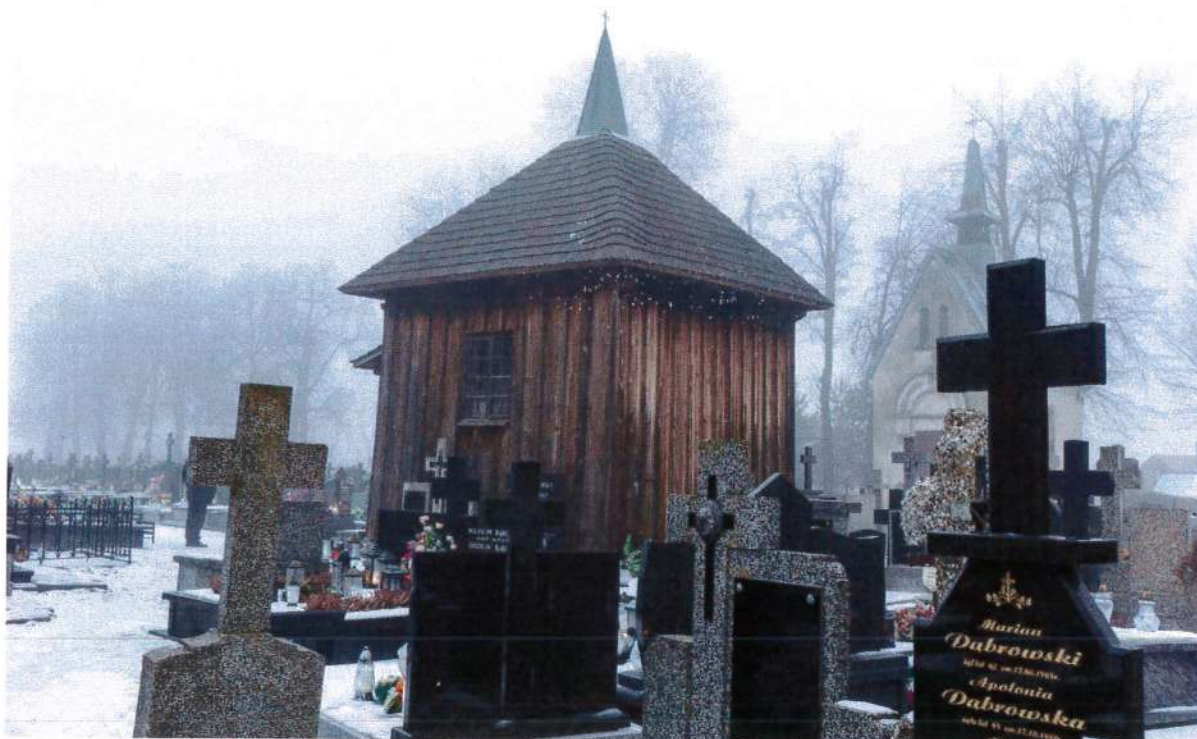
Zdjęcie kaplicy cmentarnej od południowej strony.
