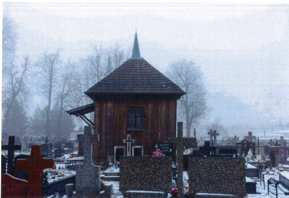
Zdjęcie elewacji bocznej kaplicy cmentarnej.
