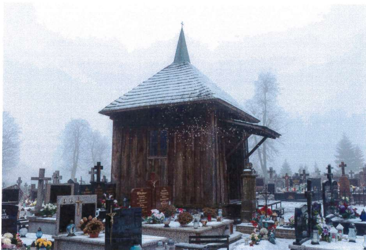
Zdjęcie kaplicy cmentarnej od północnej strony.
